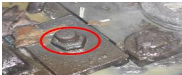
FIGURA 20.- Pernos de ajuste de la base de los postes no están estandarizados
