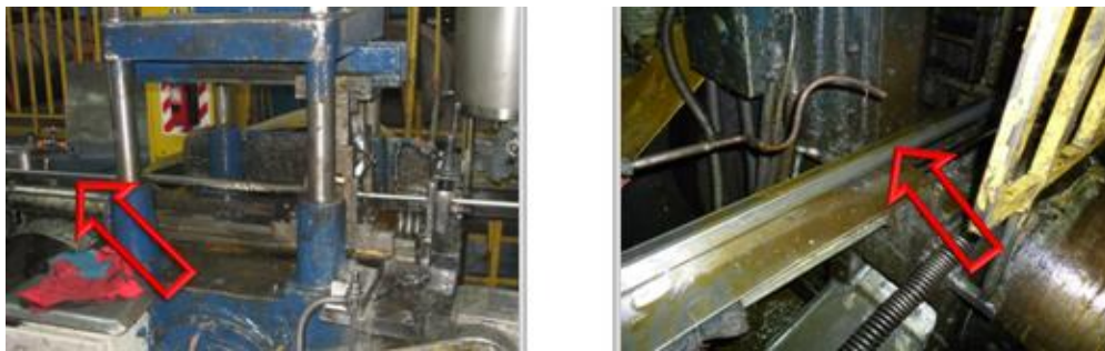
FIGURA 59.- Perdida de Aceite cuando hay fuga de aire
