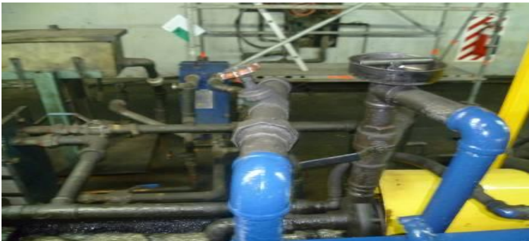
FIGURA 71.- Válvulas Hechizas en Planta.
