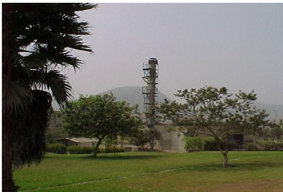
Figura N° 1. Chimenea de la PPR
